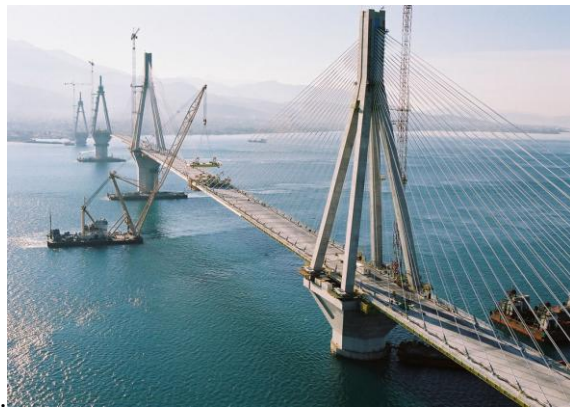
Figure 7 : Construction du tablier
