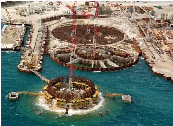
Figure 6 : Construction des embases de fondation
